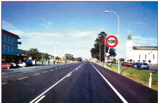
Incohérence entre la limite de vitesse affichée et le niveau de développement des abords.
