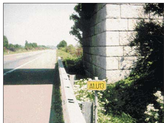
Numérotation d'un viaduc
