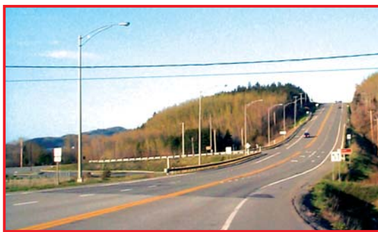
Éviter la combinaison d'une intersection et voie pour véhicules lents dans une pente
