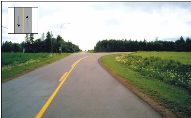
Tracé de route ambiguë : la route principale semble aller tout droit mais elle tourne à droite (possibilité de conflit de circulation).
