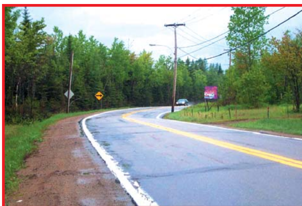
Emplacement dangereux d'un poteau en courbe horizontale
