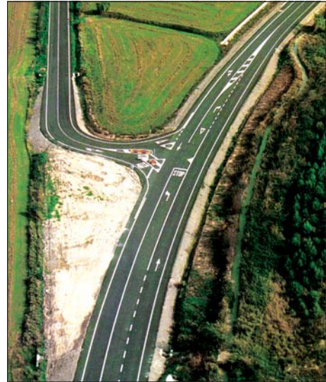
Transformation d'une intersection Y en T.
