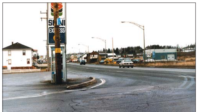
Obstructions visuelles en intersection.
