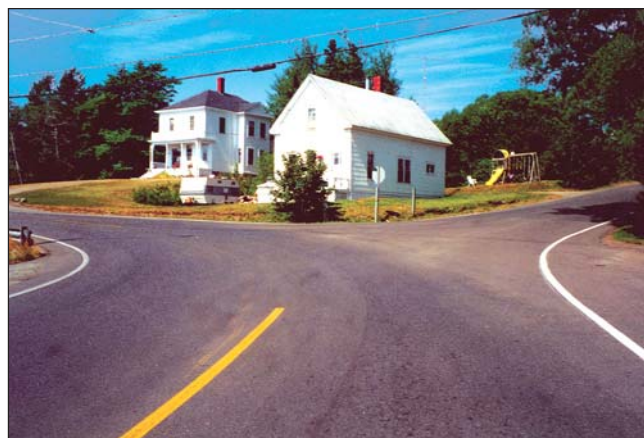
Intersection en Y pouvant engendrer des manœuvres hasardeuses (virages à vitesse élevée, conflits de circulation).
