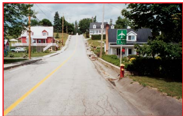
Installation de drainage dangereuse sur une route étroite en pente
