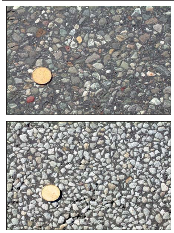
Vieillessement des granulats (Source: P. Langlois, Ministère des Transports du Québec)
