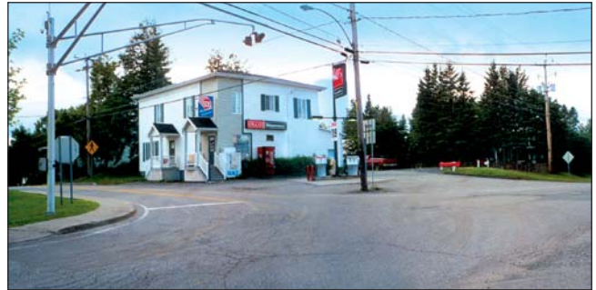
Accès à une station-service non contrôlé en intersection.
