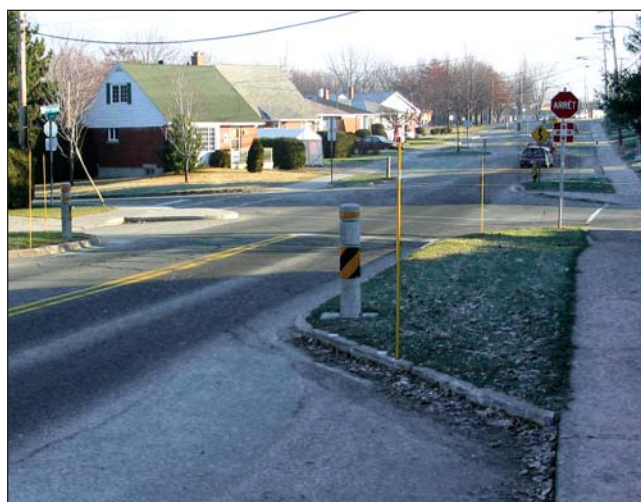
Mesure de modération de la circulation à une intersection en milieu résidentiel.
