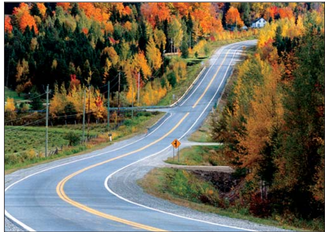
Combinaison hasardeuse : pente, intersection, accès et courbe horizontale.
