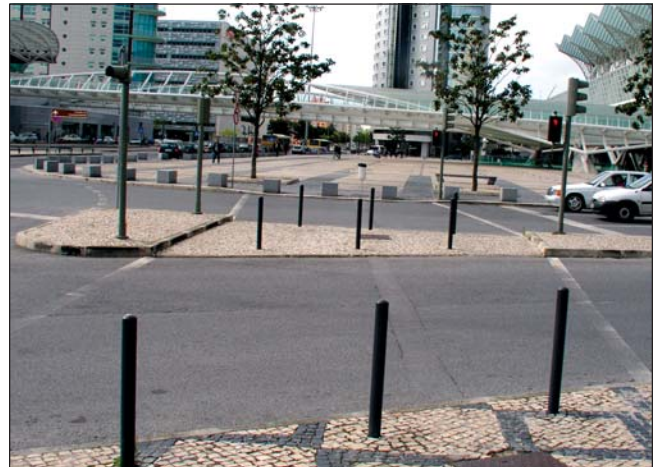
Refuge central protégé à une traverse piétonne.
