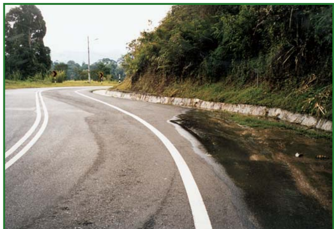
Accotement large et revêtu avec structure de drainage en pente
