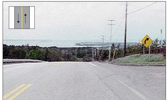
Combinaison dangereuse de tracé en plan et de profil en long : les conducteurs ne voient pas la courbe horizontale.
