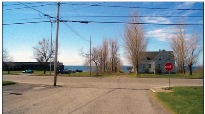
Emplacement dangereux d'un poteau d'utilité publique en intersection.
