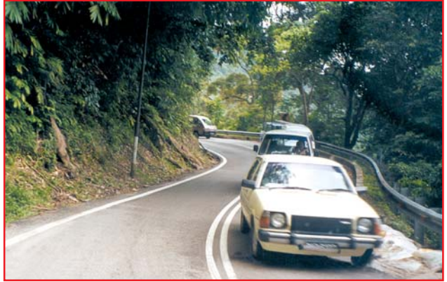
Les caractéristiques de cette route et de ses abords ne sont pas adaptées à sa fonction de mobilité et aux débits de circulation élevés.
