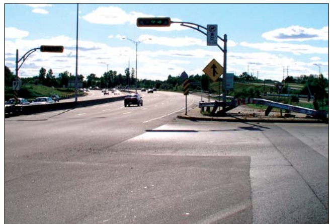
Évidence d'accidents à une intersection avec feux sur une autoroute.
