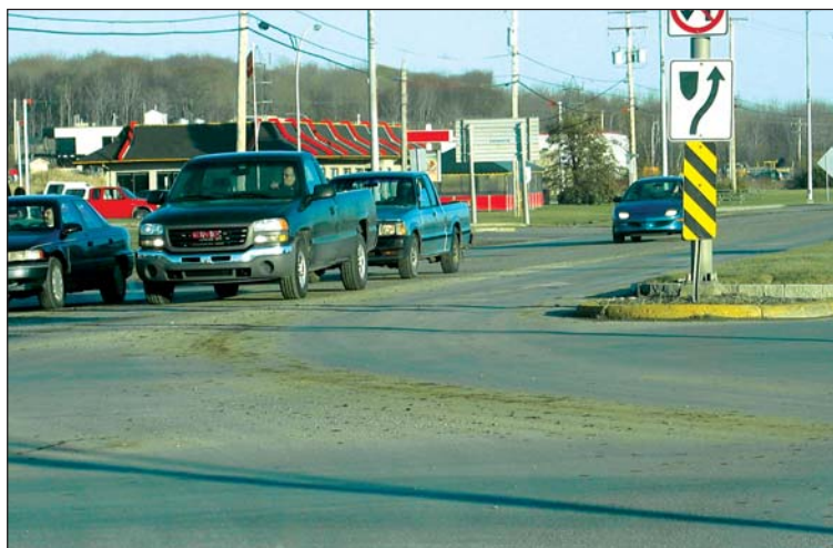
Contamination de la surface
