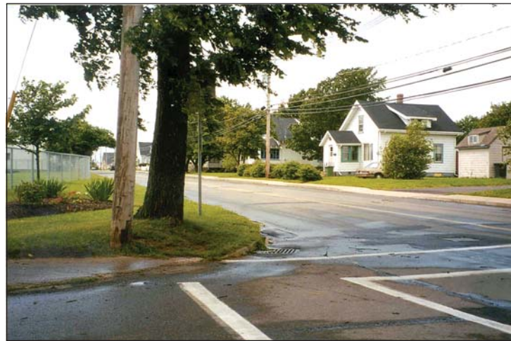
Obstructions visuelles dans le quadrant d'une intersection conventionnelle.
